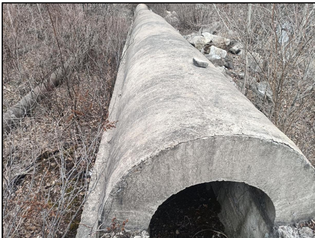
图 2-10 排水斜槽入口
