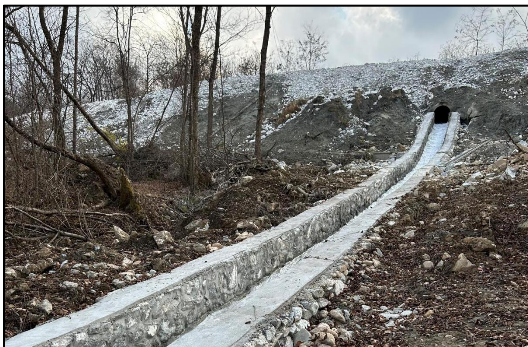
图 2-11 排水斜槽入口
