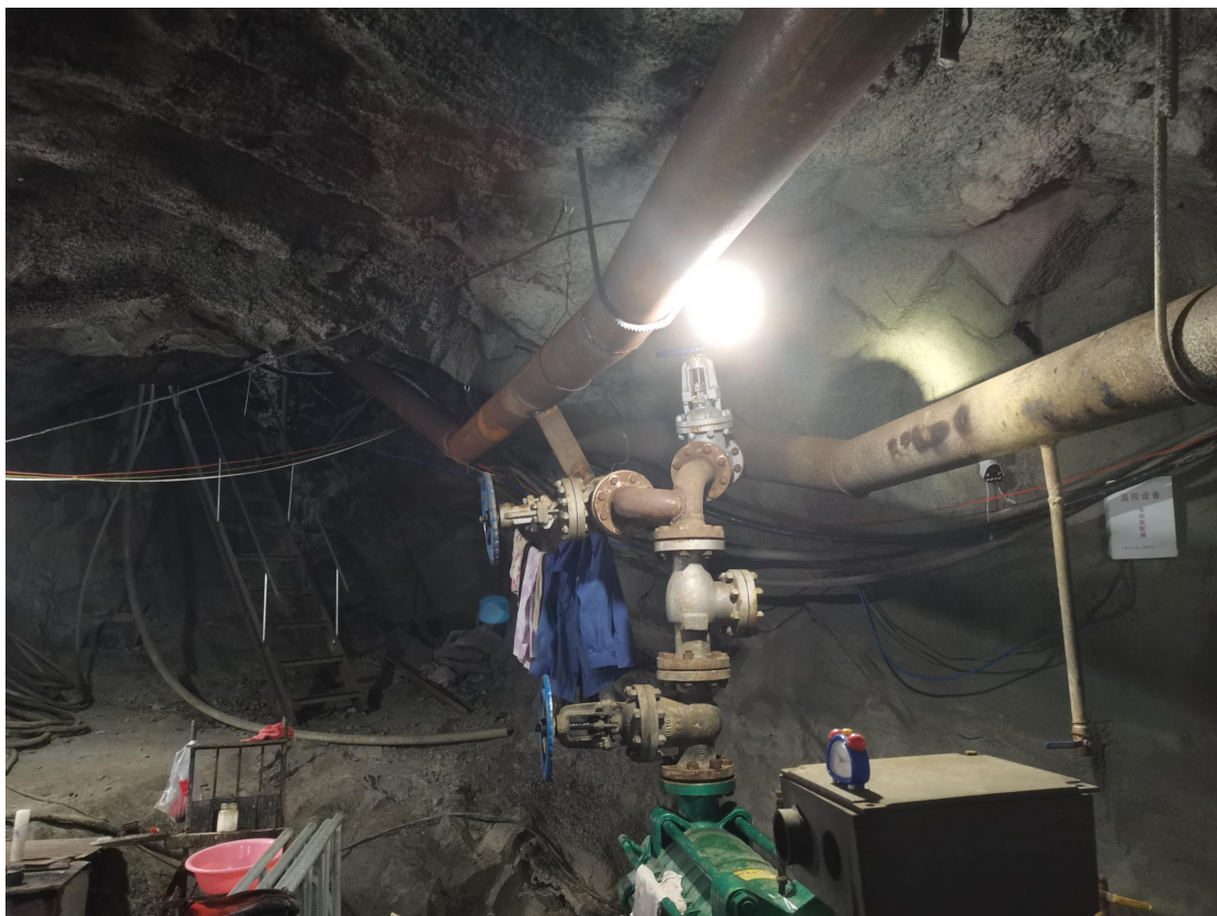
图 2-12 -200m 中段水泵站排水管
