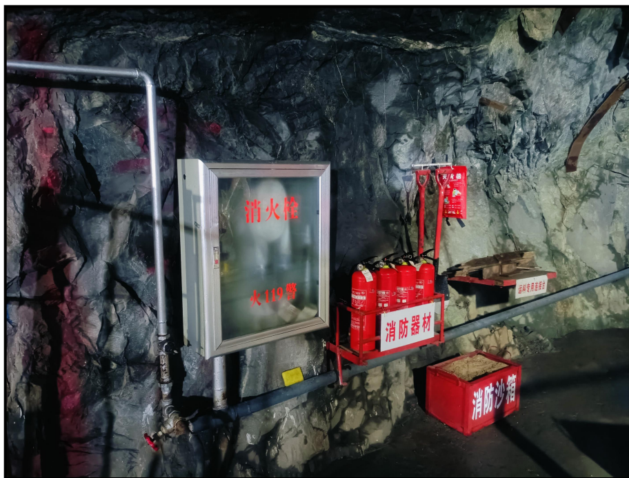
图 2-24 井下消防设施照片
