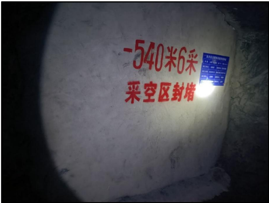
图 2-4 向阳矿采空区封闭墙照片 2
